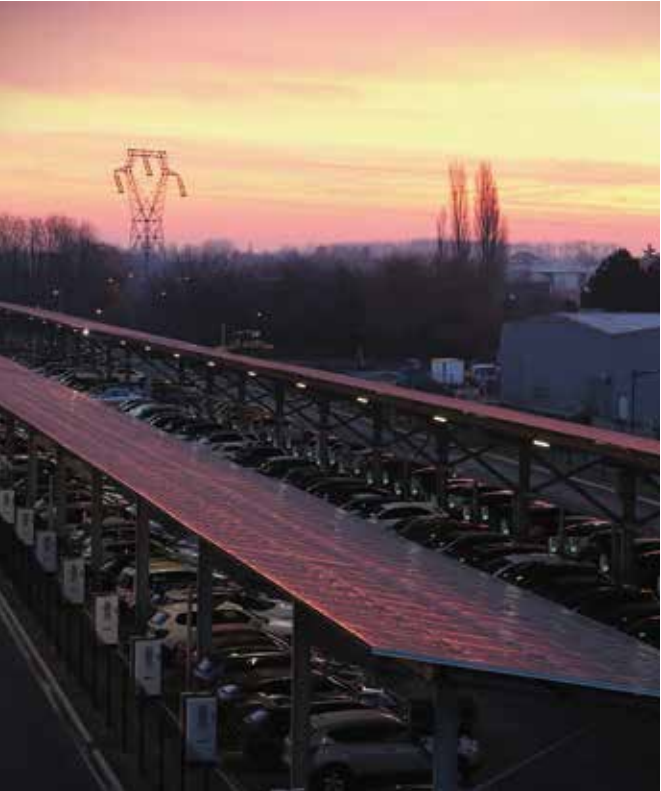
Panneaux solaires sur le parking de la Gigafactory.
