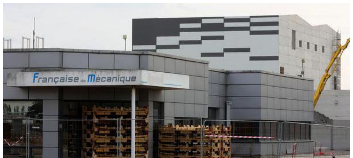
La structure de l'ancien bâtiment 7 de l'ex-Française de mécanique, conservée, n'est désormais plus visible de l'extérieur.
