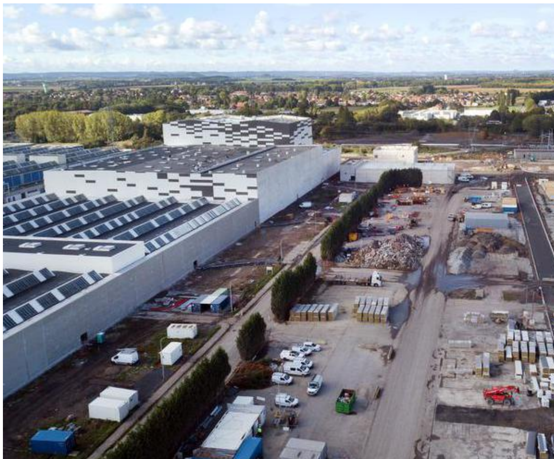
Vue du chantier à fin septembre. Sur cette parcelle, un deuxième bloc, identique au premier, en cours de construction, verra le jour en 2024. PHOTO MATTHIEU BOTTE
